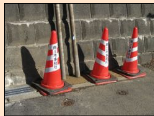
工事中の現場
