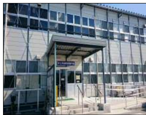
仮設の宇土市役所庁舎
